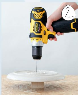
Löcher bei Markierung mit Keramikbohraufsatz bohren.
